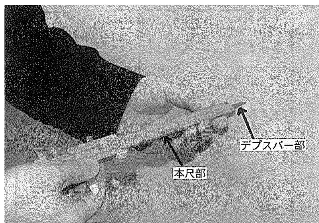
図-1.5 削孔深さの測定状況
